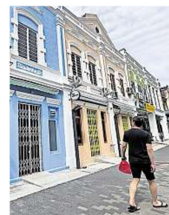
Neuer Glanz: Nach jahrelanger Restaurierung erstrahlen die alten Geschäftshäuser der Jalan Sang Guna in Pastellfarben.
