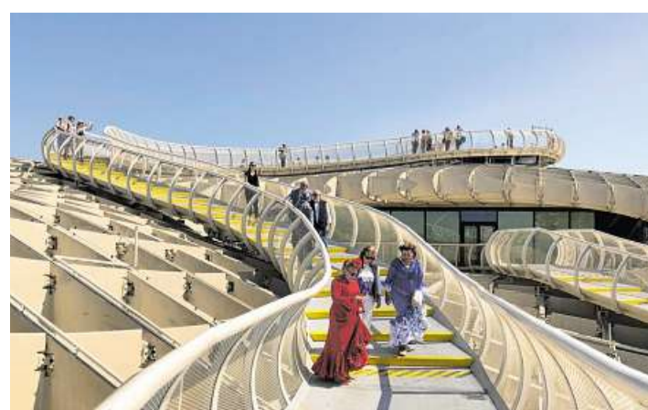
Der Metropol Parasol, eine Holzkonstruktion auf der Plaza de la Encarnación in Sevilla erlaubt einen Spaziergang über den Dächern der Stadt.
